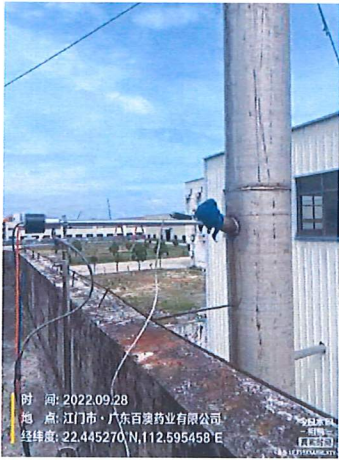
图 3: 锅炉废气排放口监测点
